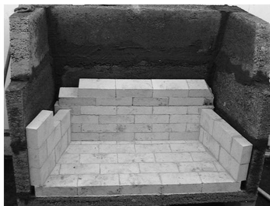
**Figure 4. Installation des briques réfractaires**
