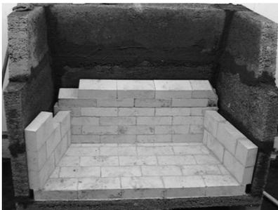
Figure 8. Installation de la brique réfractaire
