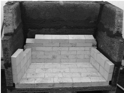
**Figura 8. Instalación de ladrillos refractarios**
