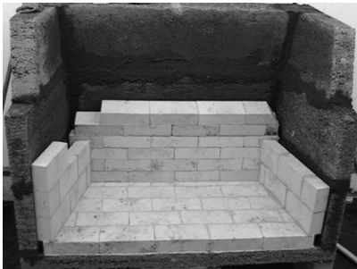
Figure 8. Installation de la brique réfractaire
