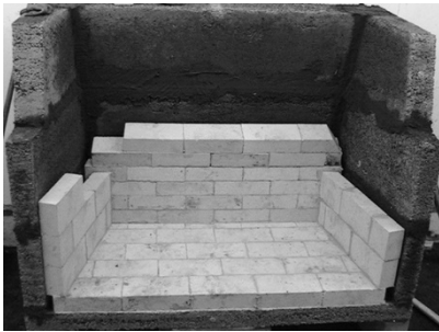
Figura 8. Instalación de ladrillos refractarios
