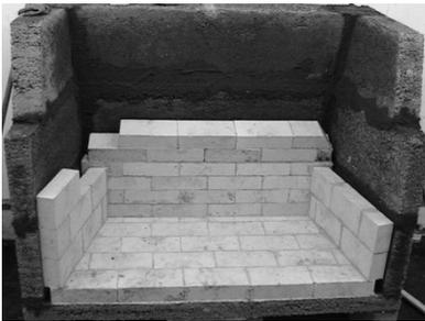
**Figure 9. Installation de la brique réfractaire**
