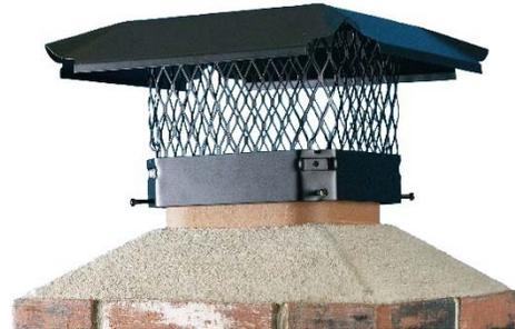
Figure 24. Capuchon de mortier et capuchon de cheminée
