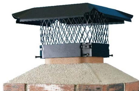
Figura 24. Tapón de mortero y tapón de chimenea
