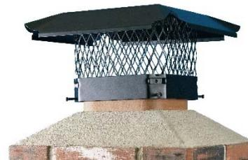
Figure 25. Capuchon de mortier et capuchon de cheminée
