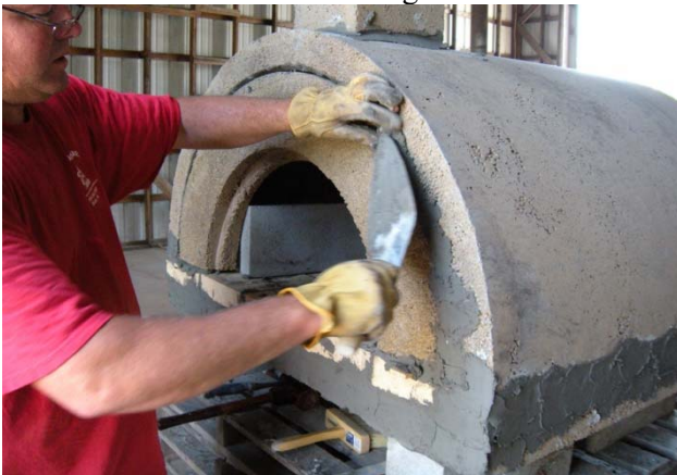
Figura 15. Instalación de la pared frontal
