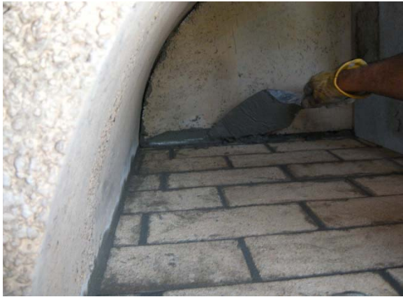
Figura 14. Juntas interiores de mortero
