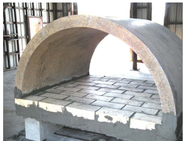
Figura 12. Instalación del techo
