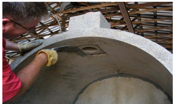
Figura 13. Chimenea de mortero en el interior del horno
