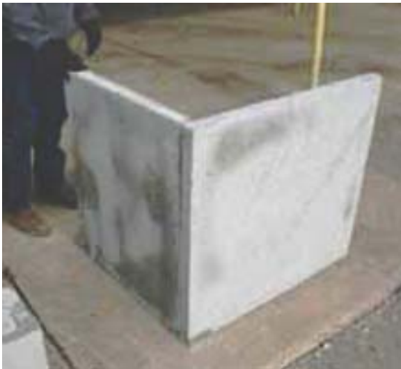
Figura 7. Colocar el panel lateral
