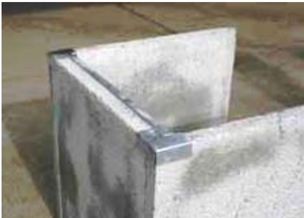
Figura 8. Instalación del panel frontal
